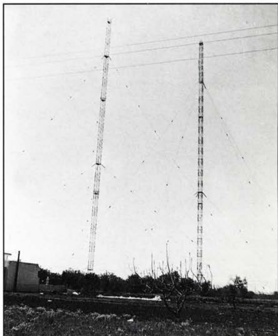
foto 1 - Esempio di tralicci radianti: antenne per trasmissioni radio broadcasting in onde medie.
