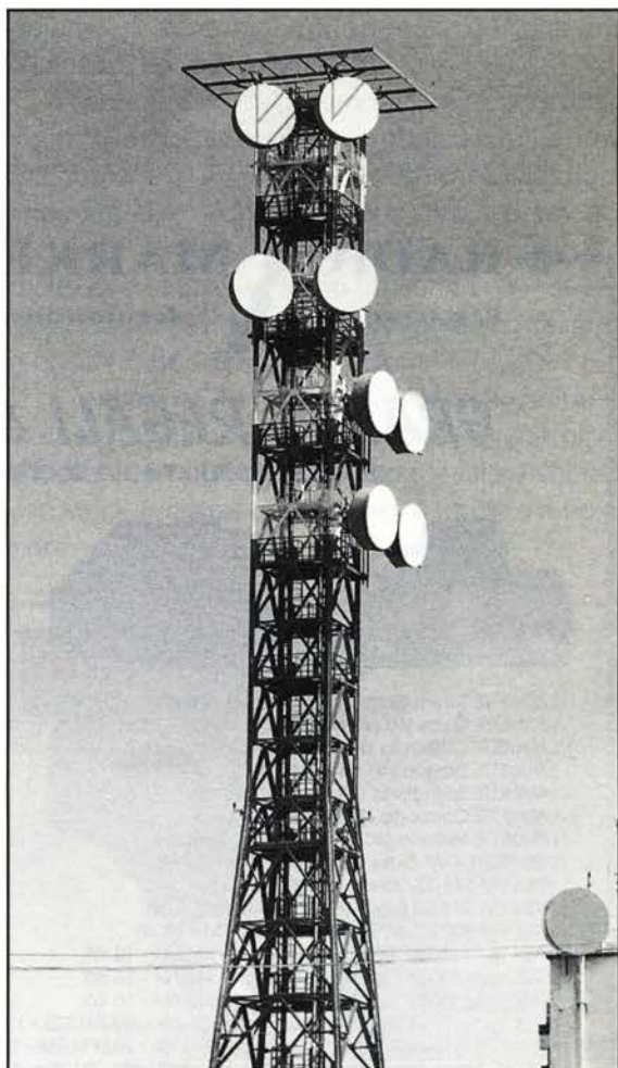
foto 3 - Esempio di sistema portante e torre per antenne a microonde per ponti radio.
